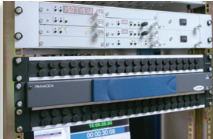
Коммутатор Panacea и другая технологическая аппаратура
